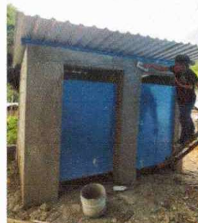
Foto 2: Sustitución de una letrina de concreto
