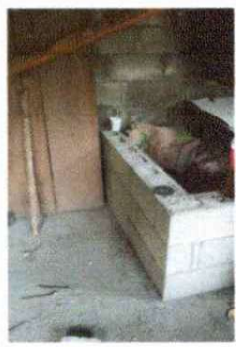
Foto 3: Reparacion de estufa Rural (Polletón)
