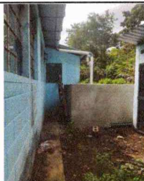
Foto2: Mantenimiento de cisterna
