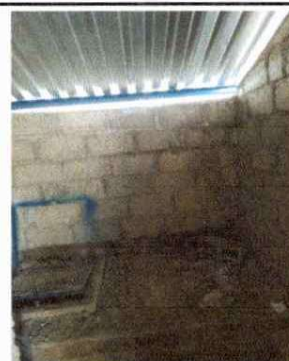
Foto 4: Reparación de cisterna
