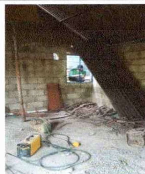
Foto 4: Sustitución de Ventanas
